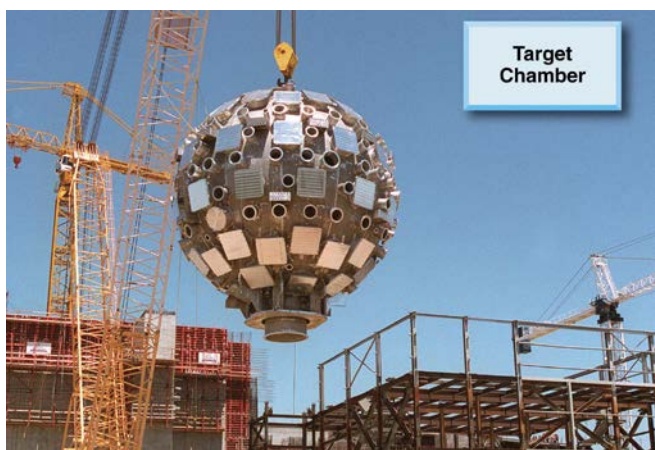
Рис. 169. Камера установки NIF перед монтажом.
