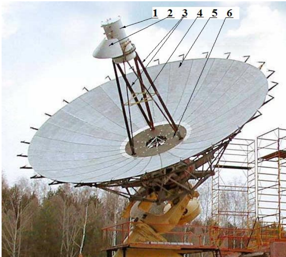
Рис. 1. Зеркало телескопа проекта «Радиоастрон» в раскрытом состоянии. 1 – фокальный контейнер, 2 – радиатор фокального контейнера, 3 – штанги, удерживающие фокальный контейнер над поверхностью зеркала, 4 – поперечные тяги, соединяющие штанги, 5 – лепестки, 6 – центральное зеркало.
